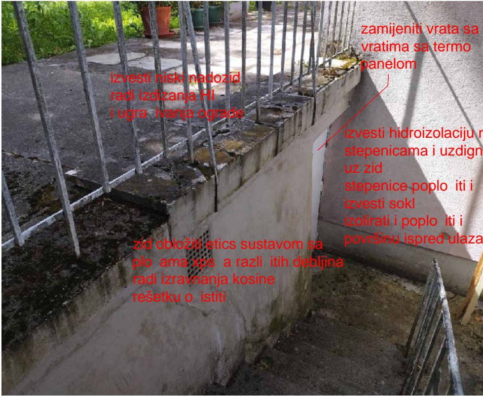
ostrugati svu boju i nestabilnu žbuku sa stropova i zidova ukopane zidove sa unutanje strane obložiti gk plo ama
