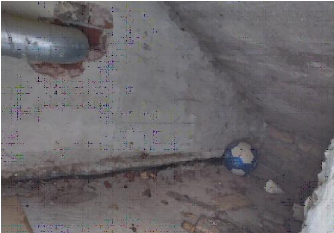
prostor ispod ulaznog stubišta zaštiti cijev ventilacije horizontalnu hidroizolaciju i uzdizanje uz podzide izvesti i sa unutanje strane
