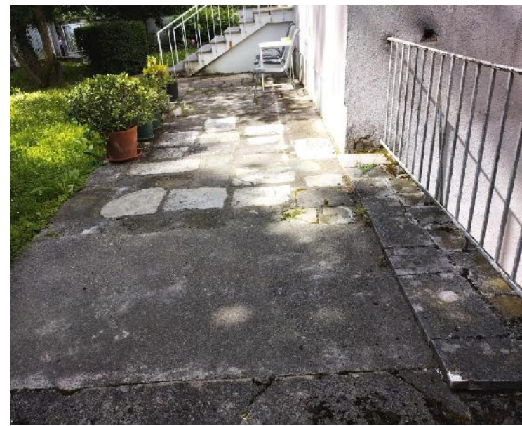
foto 2 popločenje ravni krov iznad središnjeg i stražnjeg dijela spremišta
