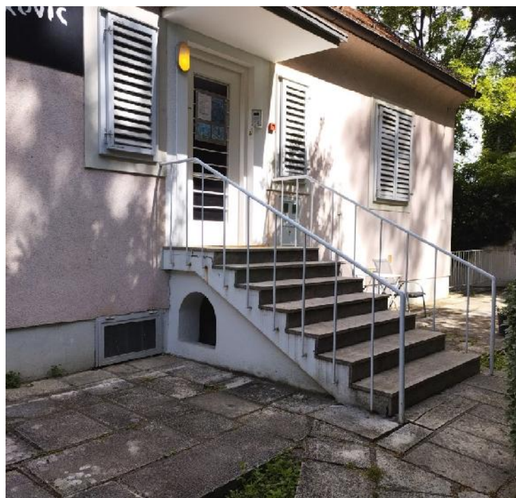
foto 1 ulazne stubište i popločenje koje je ravni krov spremišta u podrumu
