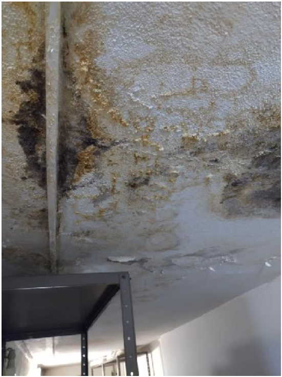
ostrugati svu boju i nestabilnu žbuku sa stropova i zidova ukopane zidove sa unutanje strane obložiti gk plo ama
