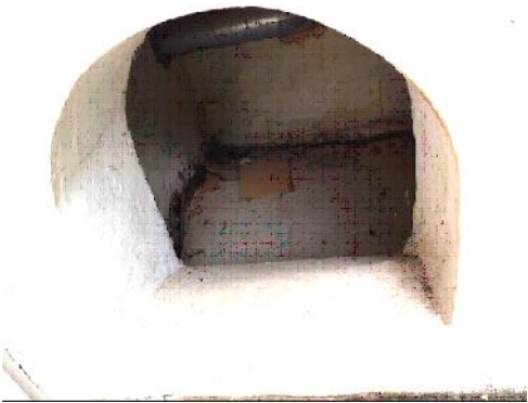
prostor ispod ulaznog stubišta zaštiti cijev ventilacije horizontalnu hidroizolaciju i uzdizanje uz podzide izvesti i sa unutanje strane
