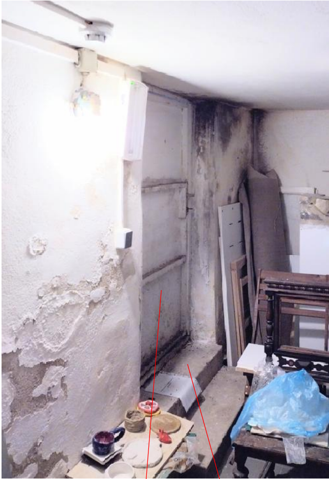
zamijeniti vrata sa vratima sa termo panelom
